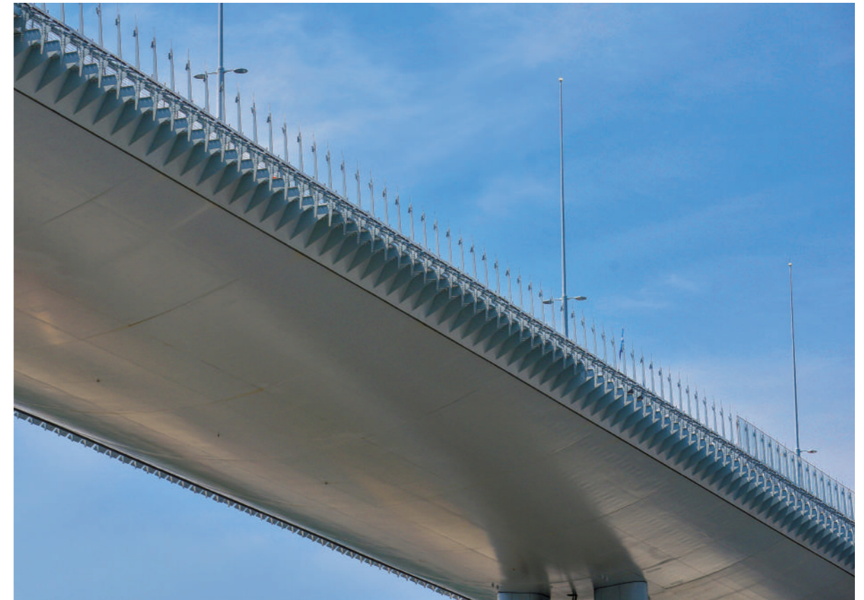
Di sopra la foto del Ponte San Giorgio di Genova ricostruito dopo il crollo (precedentemente Ponte Morandi), alcune travi e angolari utilizzati sono stati forniti da Duferco.
