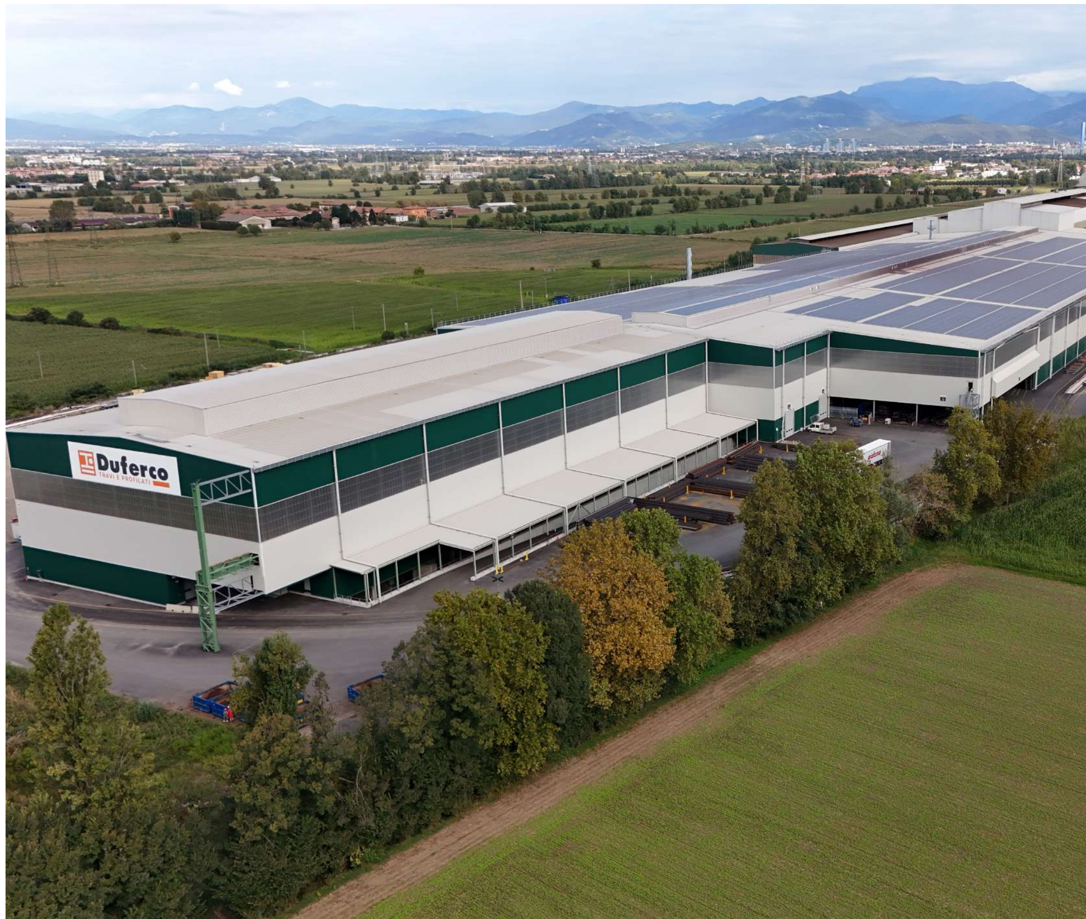
Una parte dello stabilimento di San Zeno Naviglio (capannone laminatoio), dall'alto
