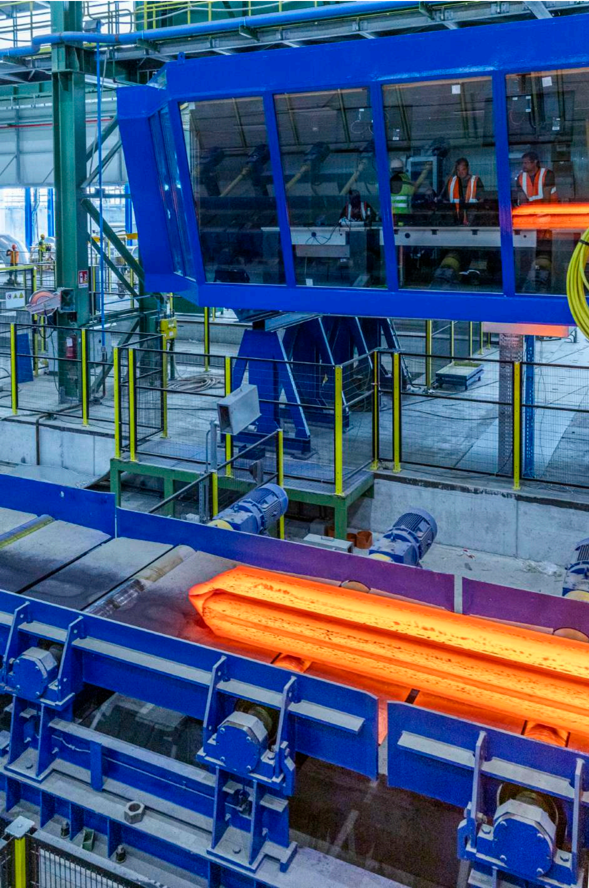
Una parte del nuovo impianto di laminazione a San Zeno Naviglio
