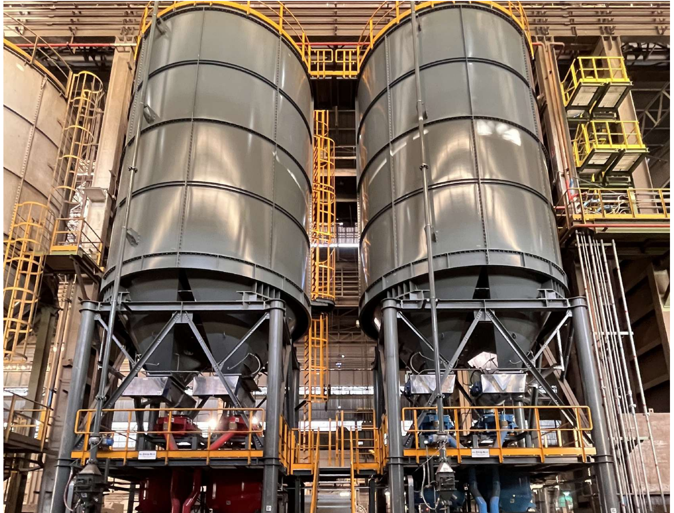
impianto di dosaggio di antracite e polimeri
